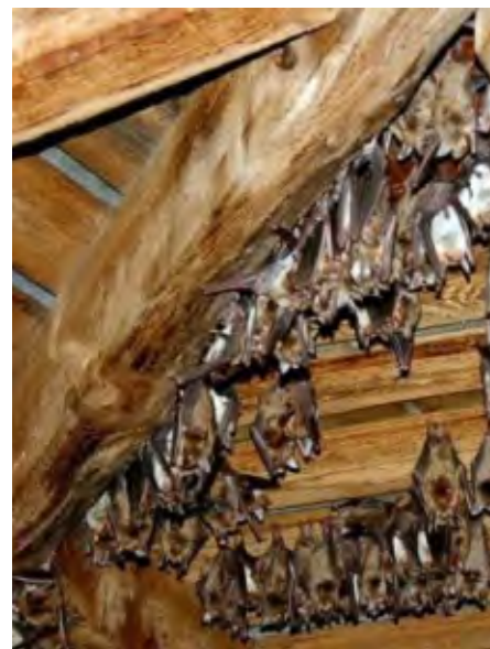
Ainsi que les charpentes que l'on peut trouver par exemple dans les combles et les clochers
